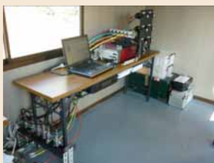
圧力計、流量計にて空気を計測し、減圧弁にて所定条件に制御します。
