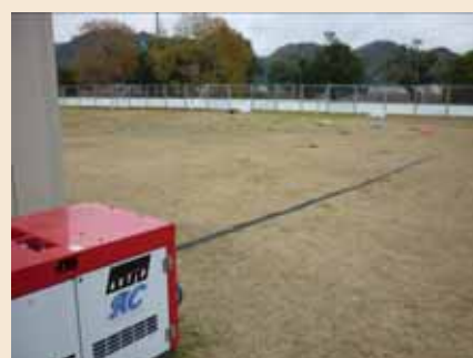
大掛かりな資機材等は不要なため、現場内は整然とした状況です。
