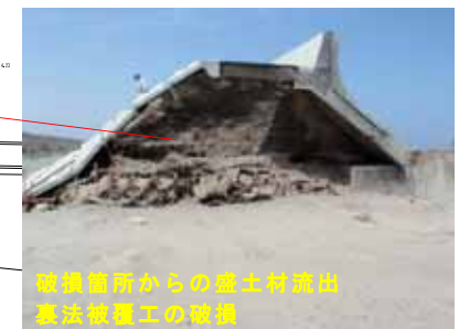
図2-10 被災概要【八太郎地区護岸】
