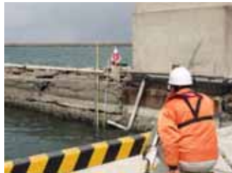
潮位観測位置及び検潮所
