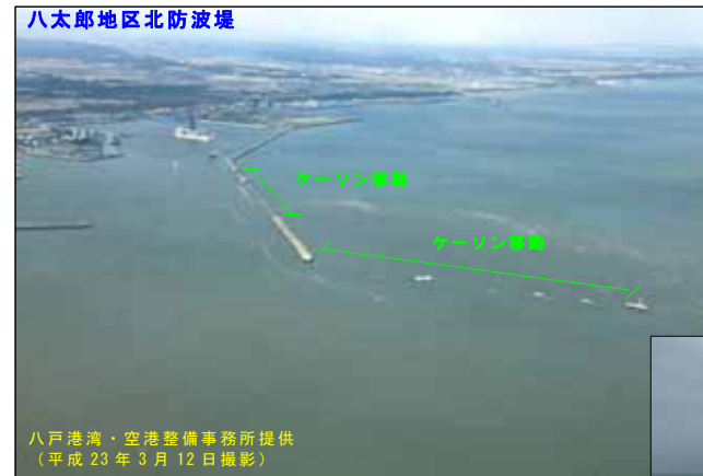
図2-2 被災後の北防波堤
