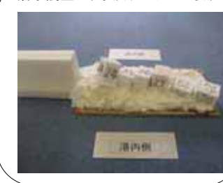
潜水調査より水没ケーソンの状況
