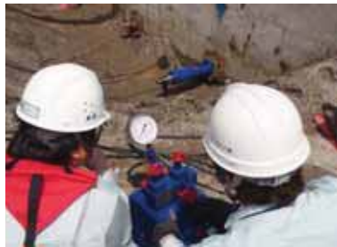
図 2.11-6 リフトオフ試験状況
