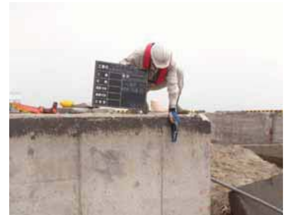
図 2.11-9 上部工傾斜角計測状況(背面レール基礎陸側)
