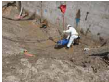
図 2.11-5 ラムチェア・ジャッキ設置状況
