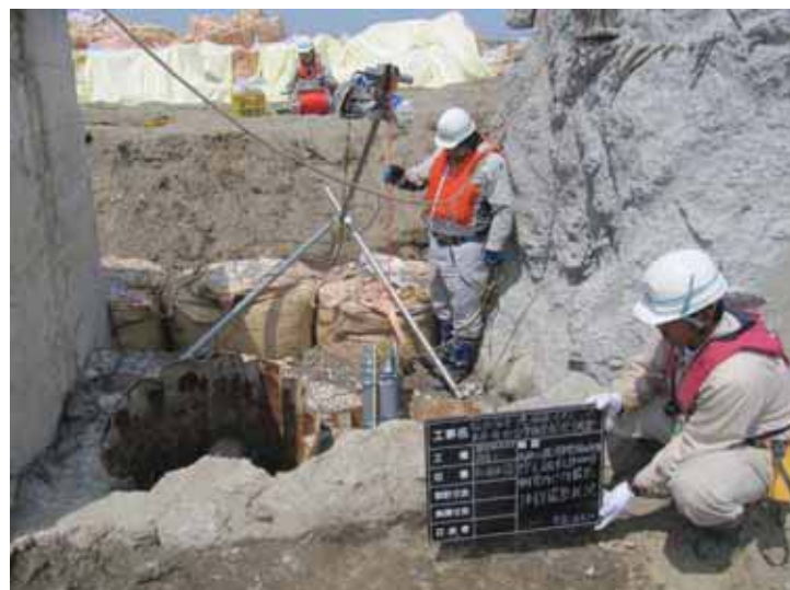
図 2.11-11 鋼管内ビデオ撮影状況(引抜杭)
