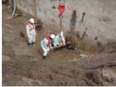
図 2.11-4 カプラー・テンションバー取付状況
