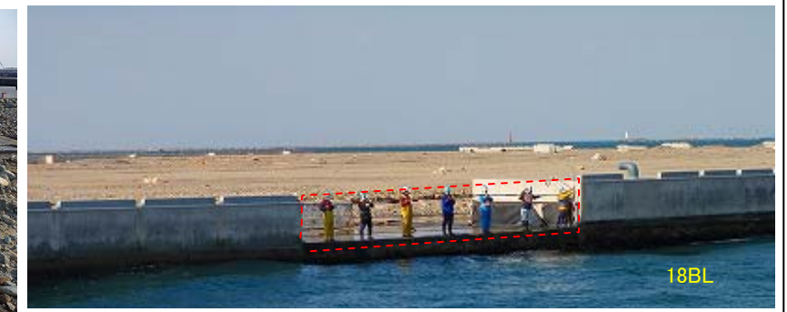
図-3 被災概要【3号埠頭岸壁】
