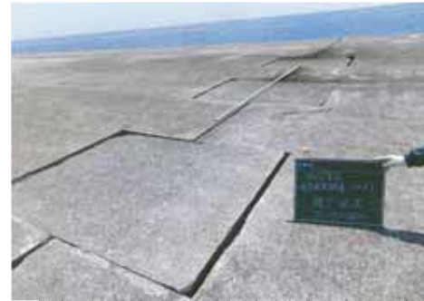
①ケーソン間の継ぎ目の拡大
