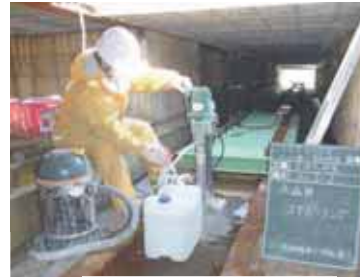
函台空洞化調査
