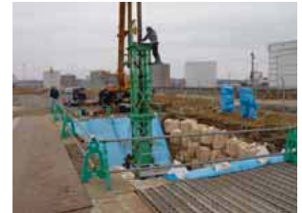
基礎杭支持力試験
