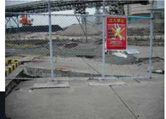
③3号埠頭との連結部
