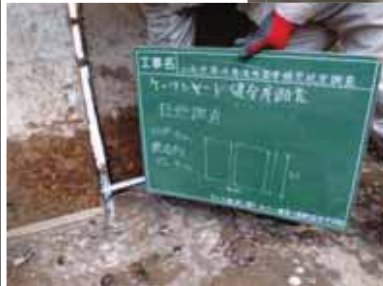
防砂目地確認調査
