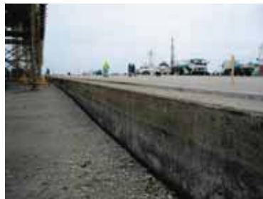
②復旧工事の着手
