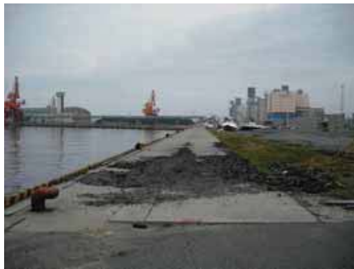
①岸壁部の状況
