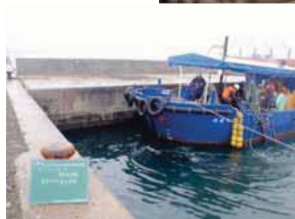
鋼矢板腐食調査
