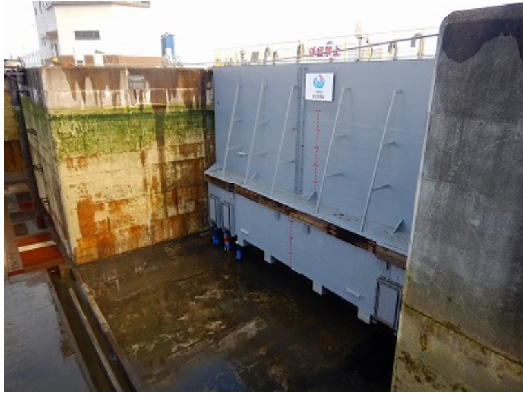
△ドックゲート据付（陸側）
