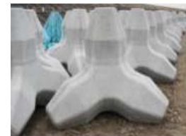
消波根固めブロック
