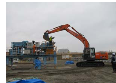
コンクリート廃材投入
