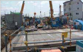
現場全景(Super Jet施工状況)
