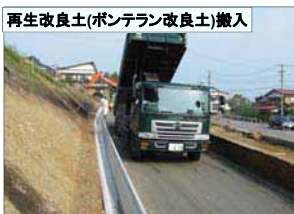
再生改良土(ポンテラン改良土)搬入
