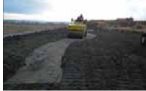
改良土の締固め(イメージ)
