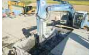
改良土の締固め(イメージ)
