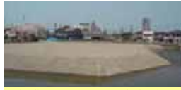
実際に施工された現場においても、乾湿繰り返しによる劣化がなく、改良土が崩壊しない。
