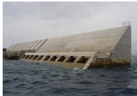
現地の巻き止め状況
