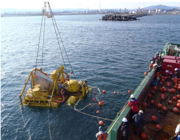
新ケーブル敷設用機器
