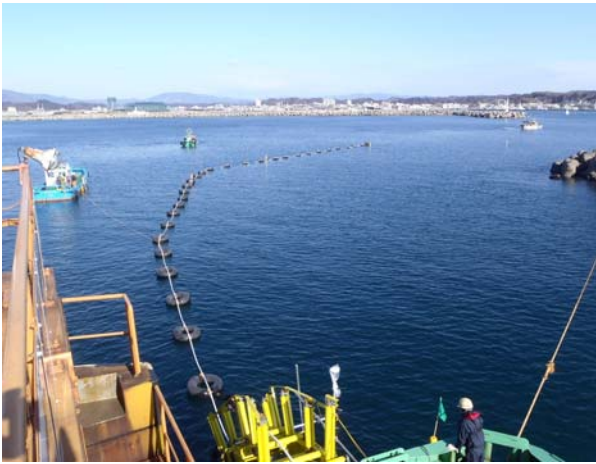
新ケーブル敷設状況
