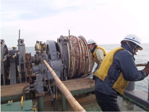
旧ケーブル撤去
