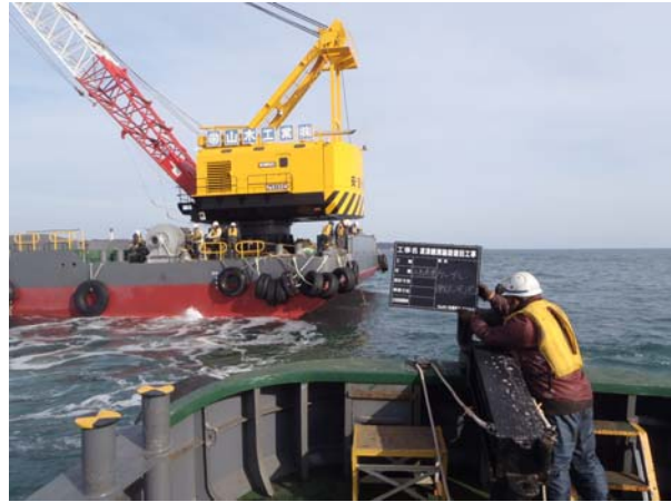
旧ケーブル撤去
