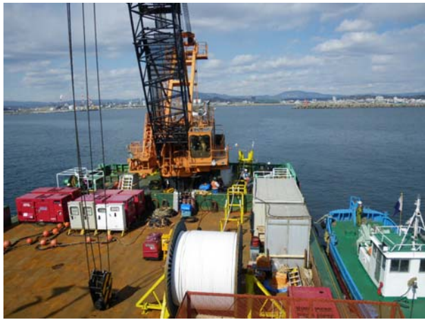
新ケーブル敷設状況
