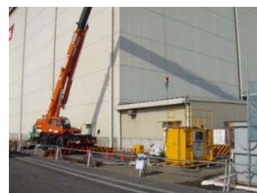
写真-1 施工状況
