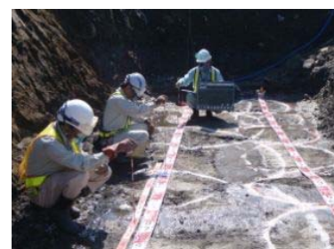
写真-2 造成された改良体
