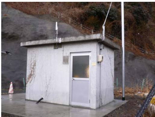
観測施設復旧（既設）
