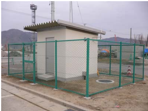
観測施設復旧（地中部マンホール内）
