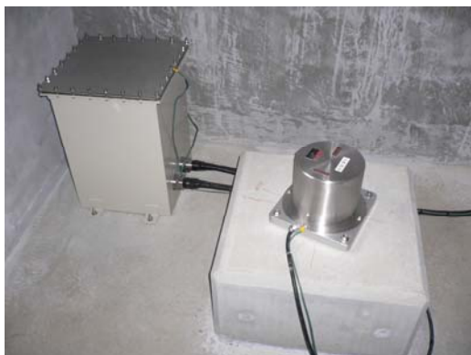
強震計機器（地上部）
