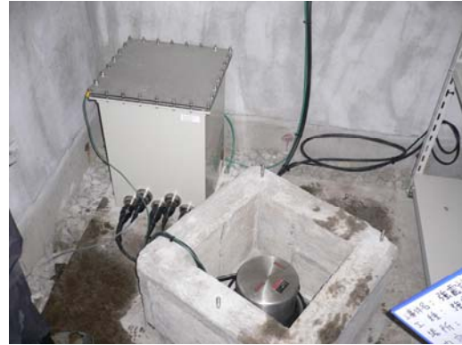
強震計、観測機器（地上部）
