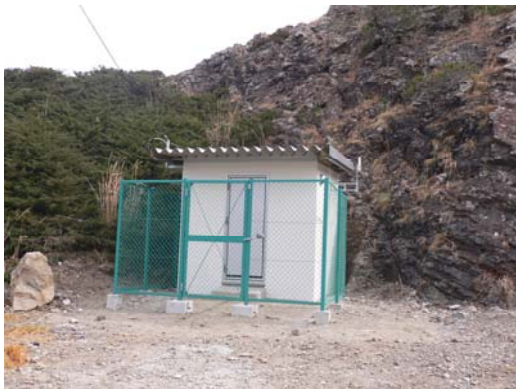
観測施設復旧（新設）
