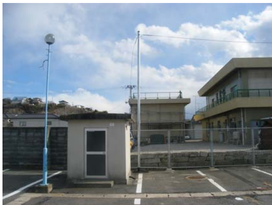
観測施設復旧（既設）
