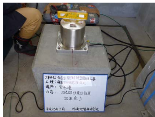
強震計観測機器（地上部）
