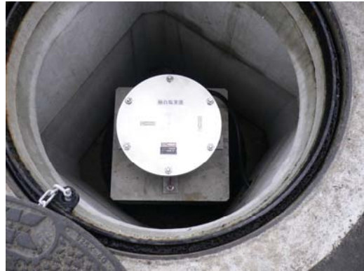
強震計機器（地上部ハンドホール内）
