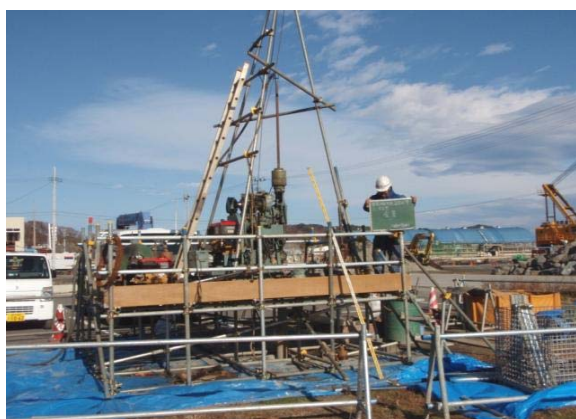
ボーリング作業中
