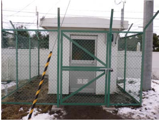
観測施設復旧（既設）
