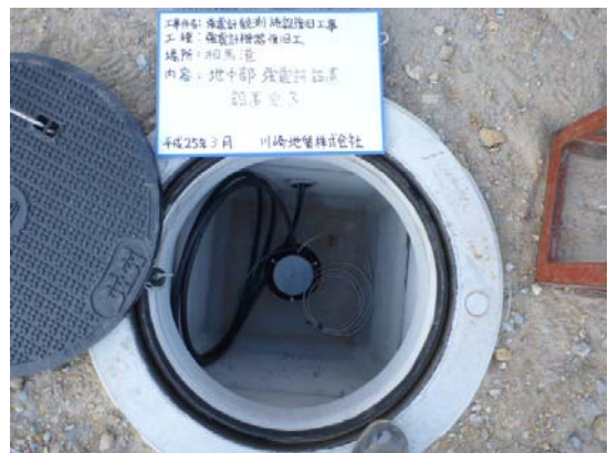
強震計（地中部）
