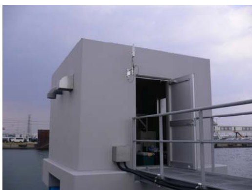
観測施設復旧（新設）
