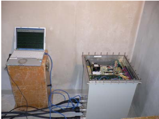
強震計機器（内部調整）
