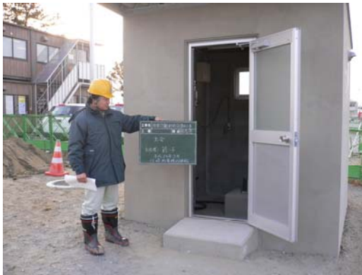
観測施設復旧（新設）
