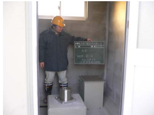
強震計機器（地上部）
