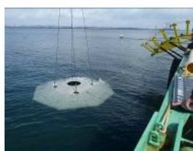
海象計架台設置状況
