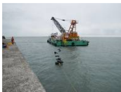
海上ケーブル敷設状況
