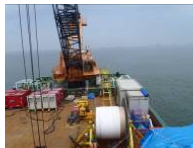
海上ケーブル敷設状況 (船上)
