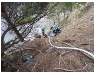
陸上ケーブル敷設状況
