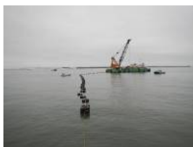
海上ケーブル敷設状況
