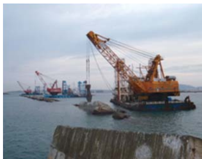
45 t 級碎岩棒による破碎（八戸港）
