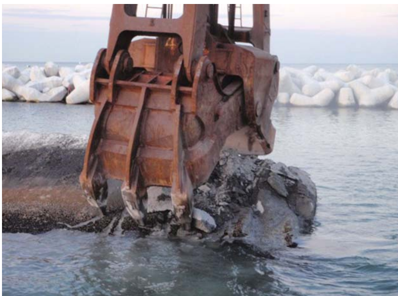
スーパーヘビー級グラブバケットによる破碎（八戸港）
