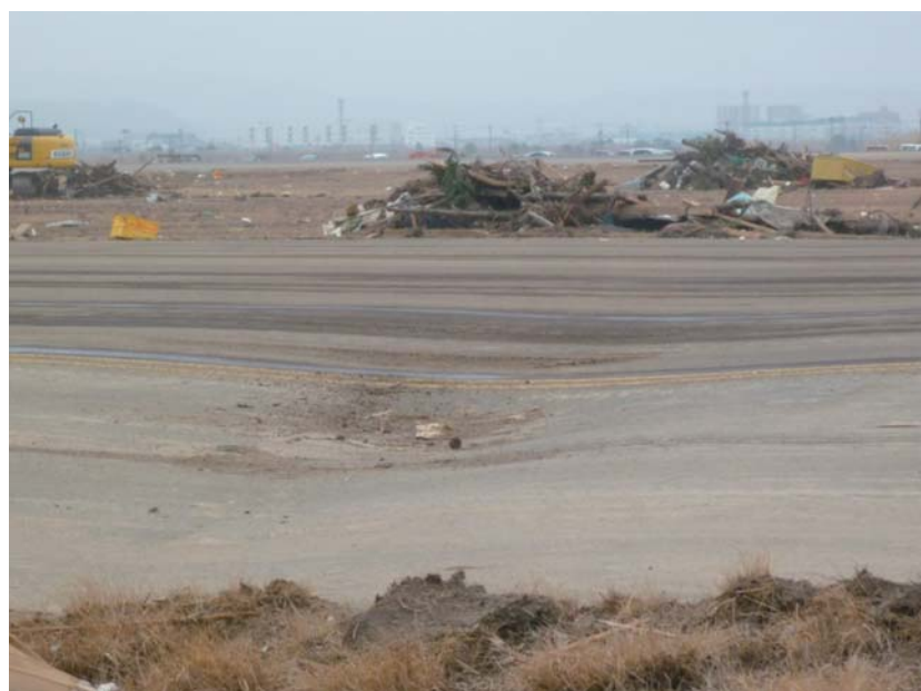
液状化対策未施工（誘導路）沈下あり
