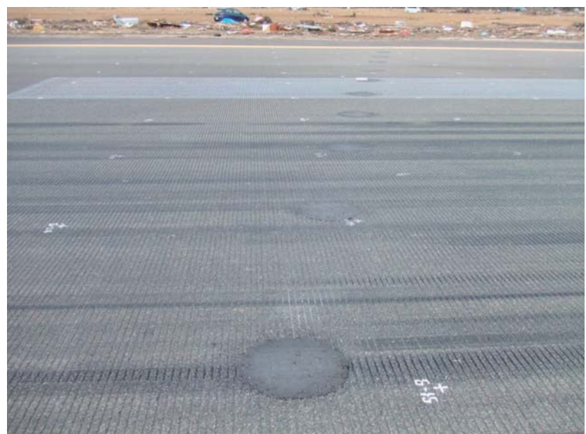
液状化対策施工（滑走路）被害なし
