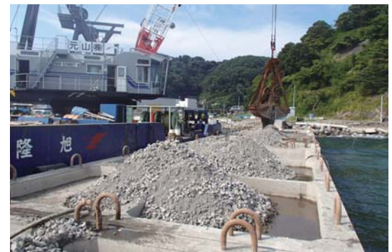
新規の防波堤への中詰め（宮古港）
