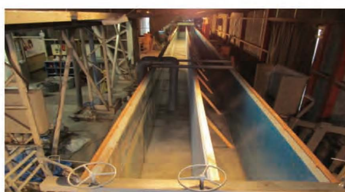
上から見た状況
