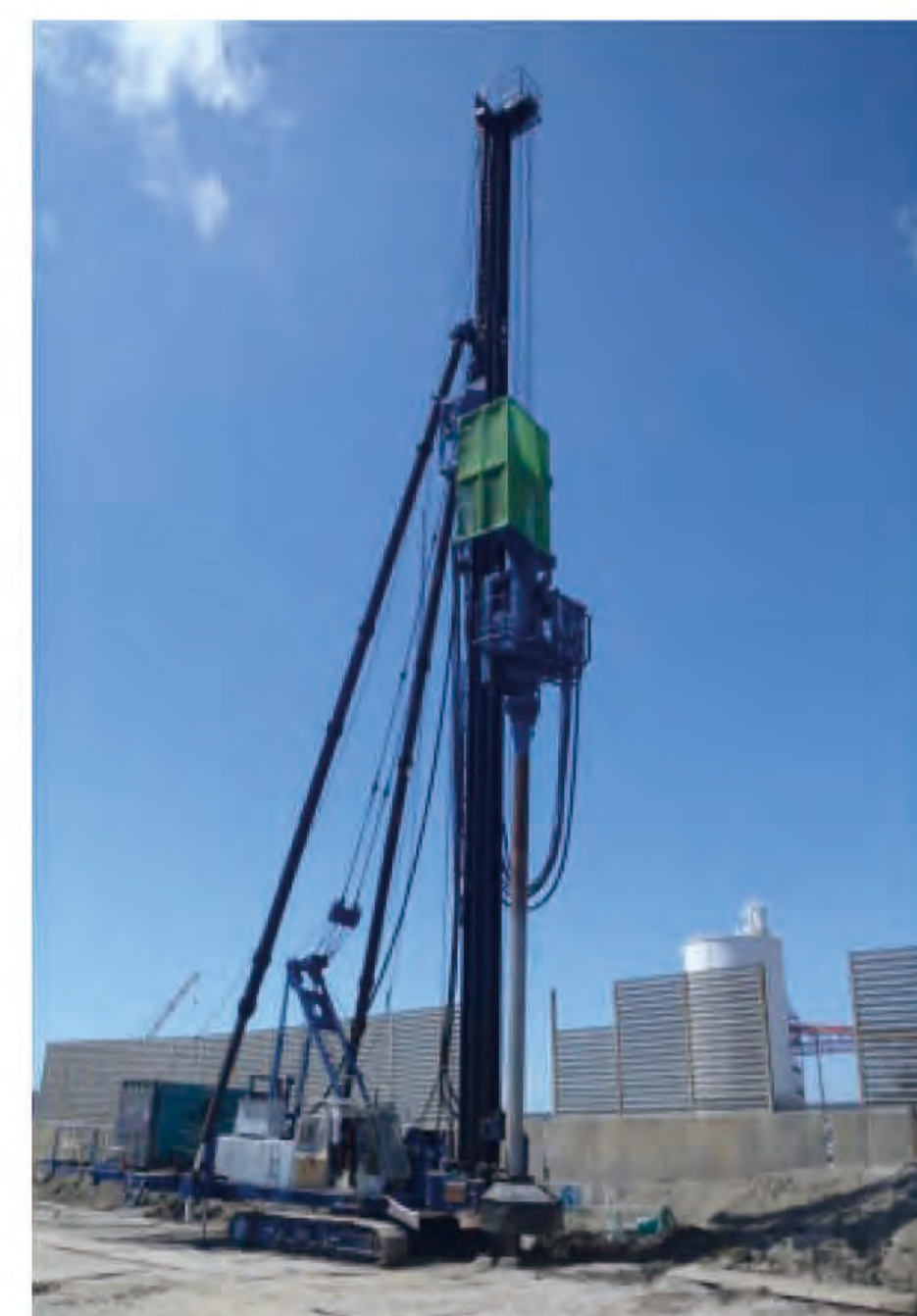
施工状況 (7号小頭)
