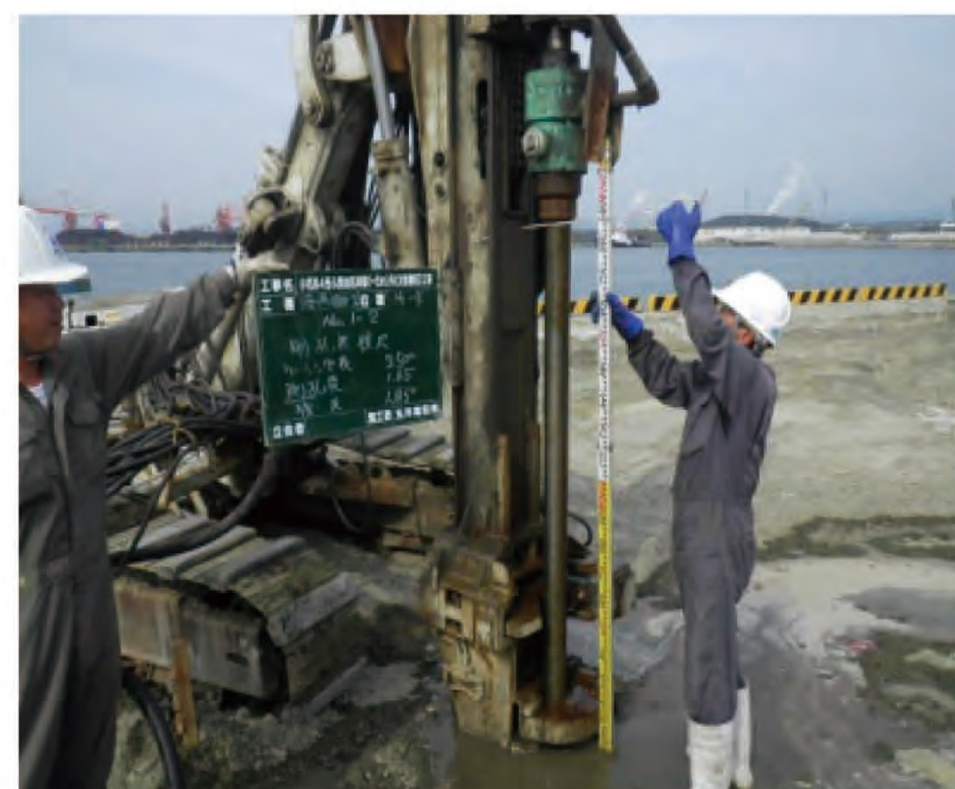
施工状況 (4号小頭)
