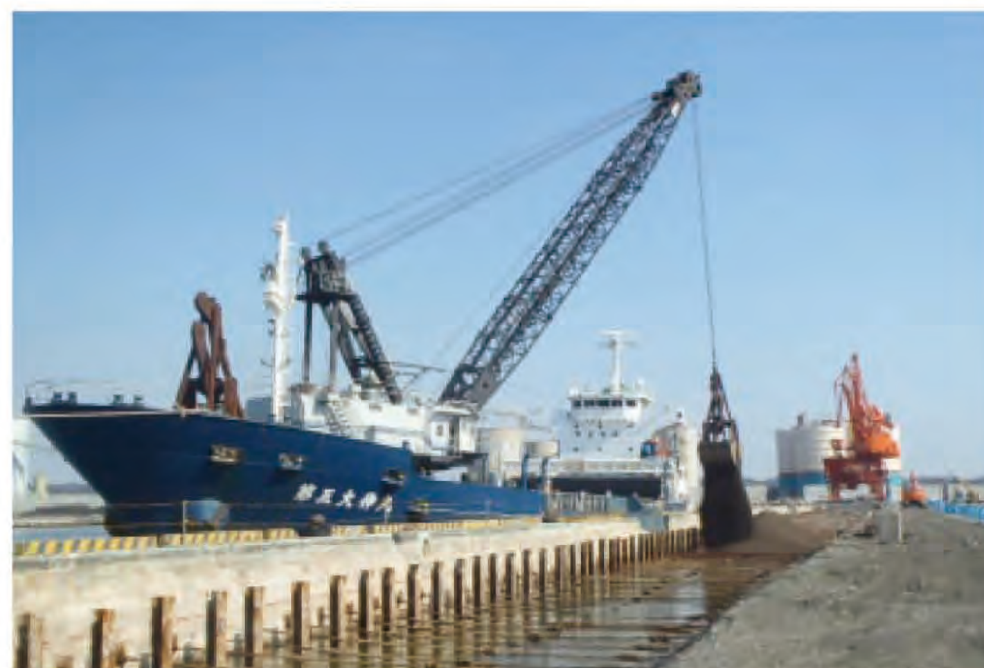
施工状況 (3号ふ頭)
