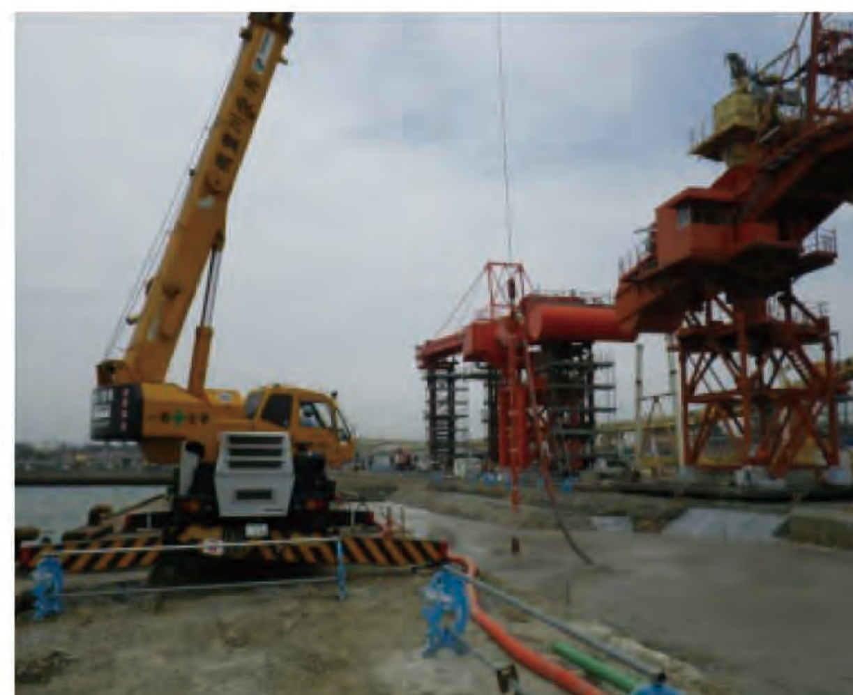
施工状況 (7号ふ頭)
