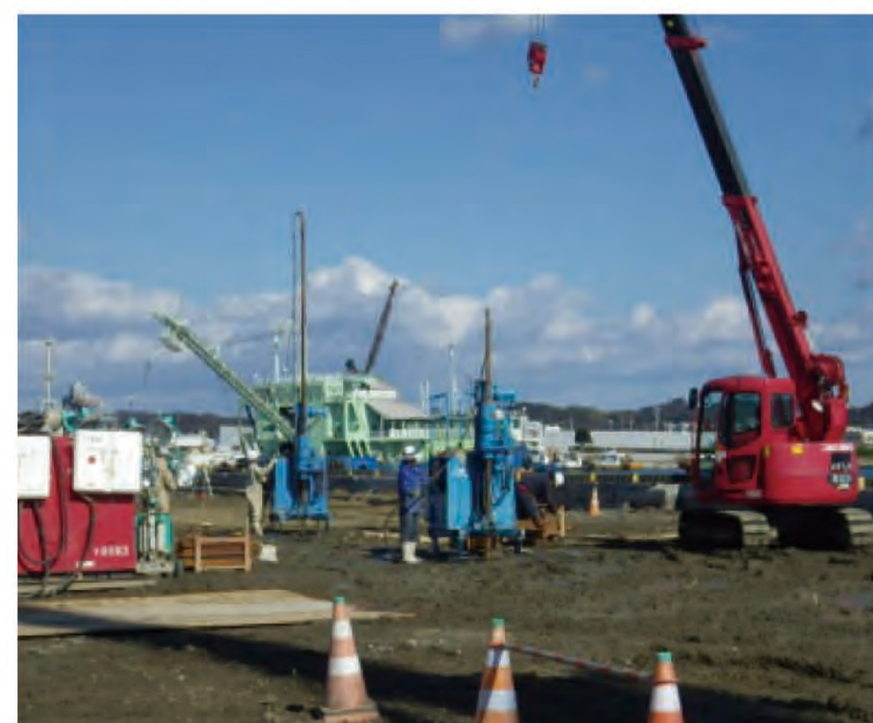
施工状況 (3号小頭)
