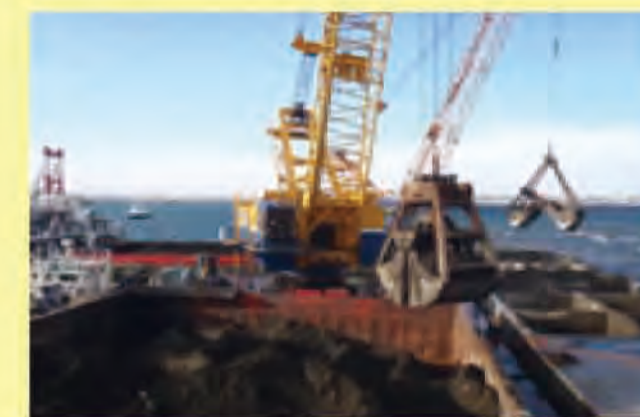
津波堆積土砂とコンクリート殻投入状況
