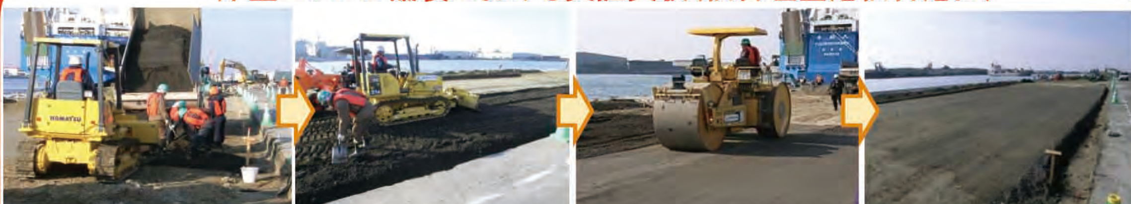
運搬・積み下ろし ブルドーザによる敷きならし 振動ローラによる締め固め 路床完成
