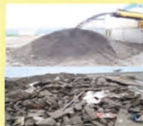
津波堆積土砂一次分級状況
