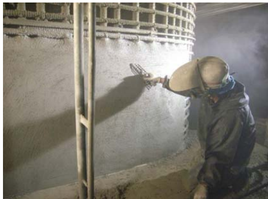
⑤ コテ仕上げ状況
