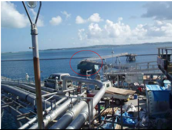
搬送距離 水平 300m で 施工可能
