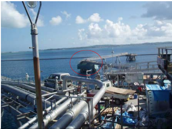
搬送距離 水平 300m で 施工可能
