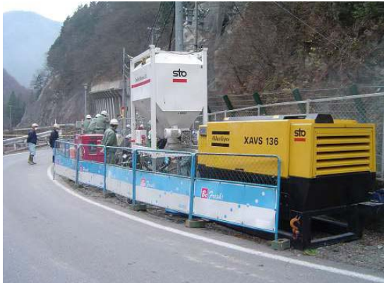
一車線 プラント設置
