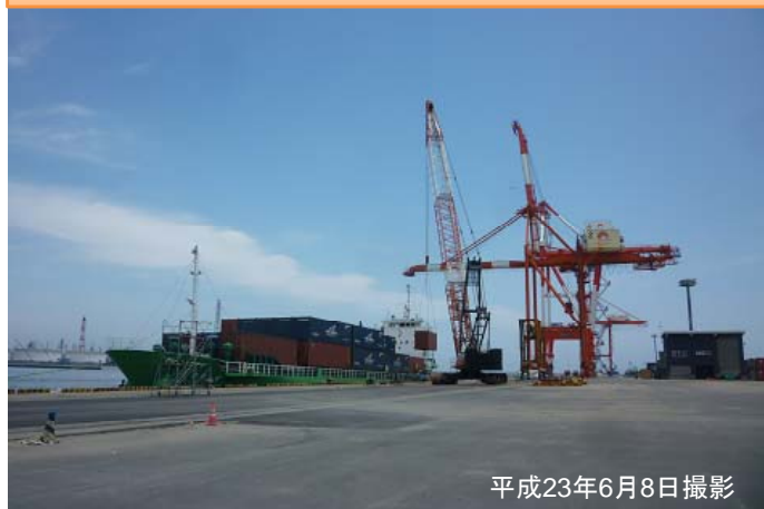
6月8日 震災後初となるコンテナ船が入港
