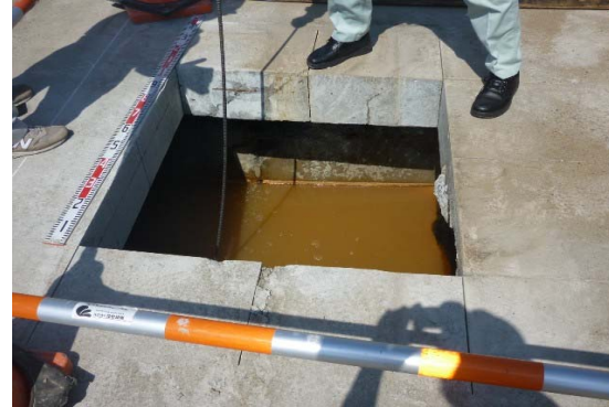
○コアNo.2の周辺を1m×1mで切断し開口部を設けた。
