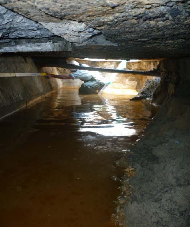
○開口部から内部を撮影
