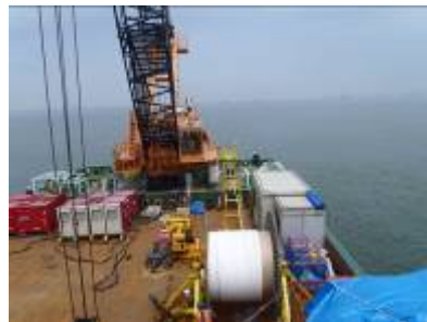
海上ケーブル敷設状況 (船上)
