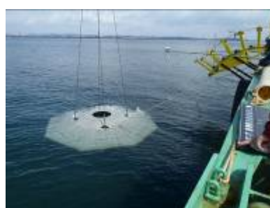
海象計架台設置状況
