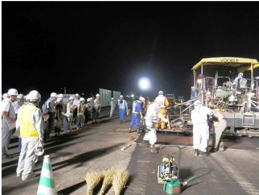
B滑走路のアスファルト舗装の様子
