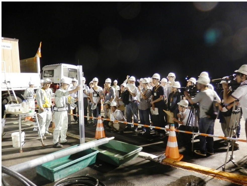
C誘導路の浸透固化処理工法のデモンストレーションの様子
