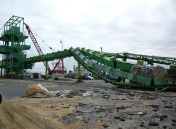
(左) 仙台塩釜港仙台港区 中野1号岸壁 震災後
