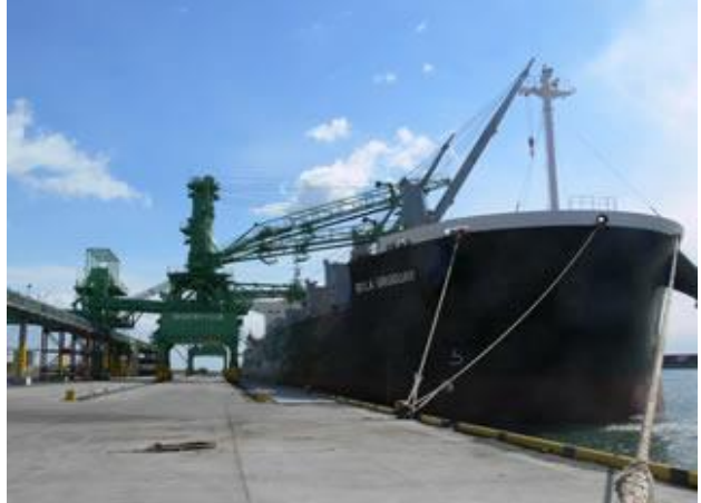
(右) 仙台塩釜港仙台港区 中野1号岸壁 復旧後
