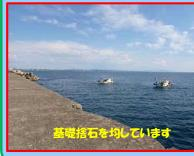
工 事 名:向浜ふ頭用地造成工事 01-Z401-K4 施工業者:(株)沢木組·高橋秋和建設(株) 工事内容:護岸を作っています。 進捗状況: 15.0% 令和2年3月27日 ~ 令和2年11月30日
