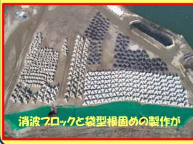
消波ブロックと袋型根固めの製作が
