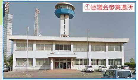
秋田県建設部 秋田港湾事務所
