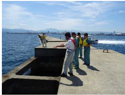
▲防波堤スリット構造を見学
