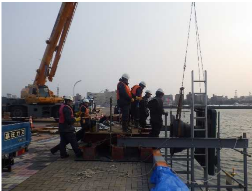
▲防舷材取付作業の様子
