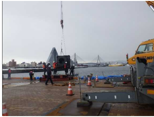
▲防舷材取付作業の様子
