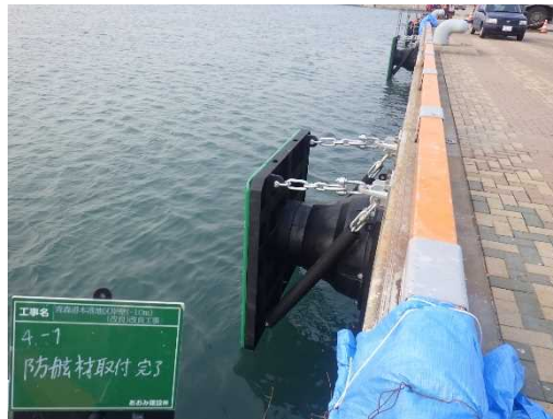
▲取付完了の防舷材
