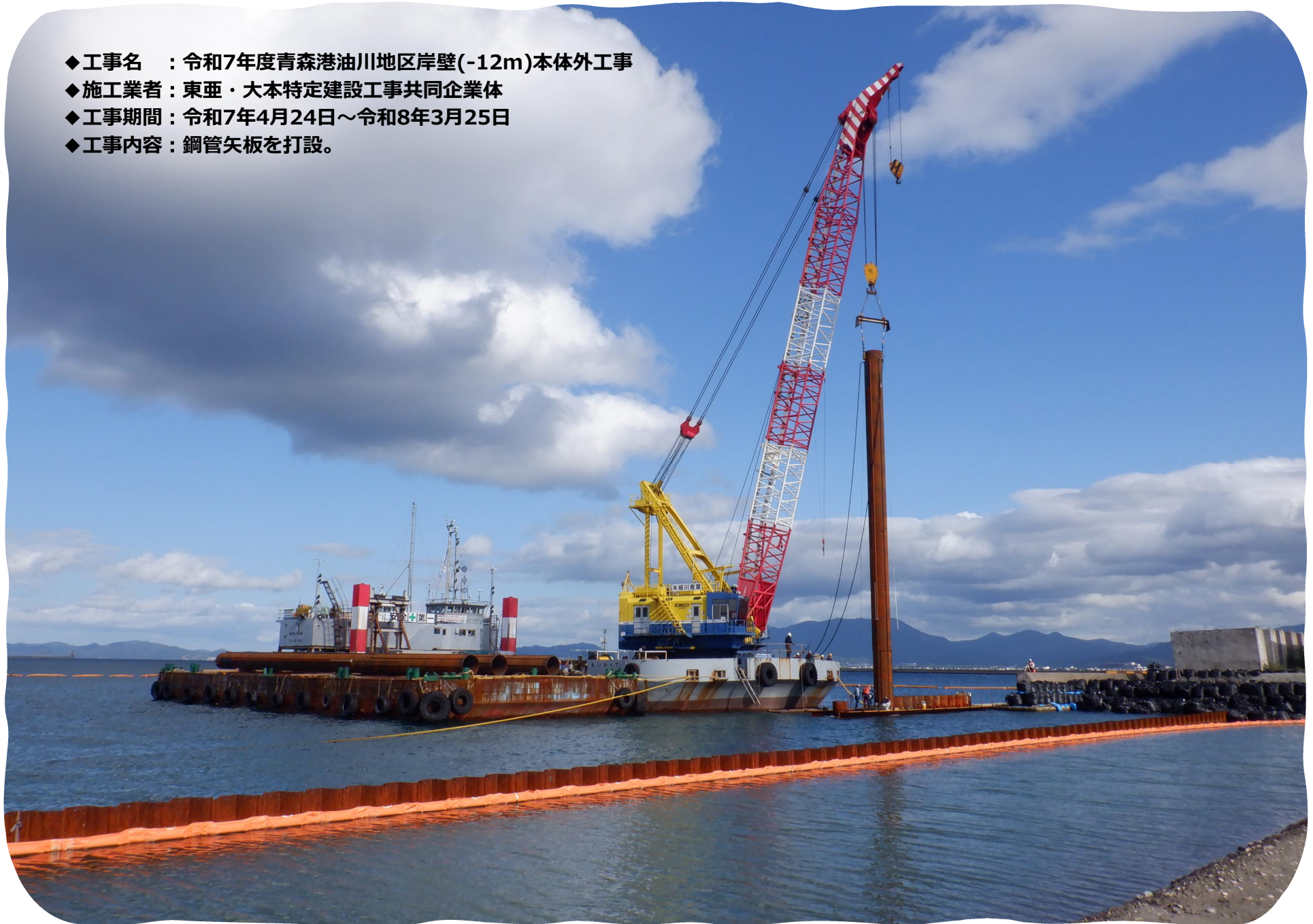
鋼管矢板打設
