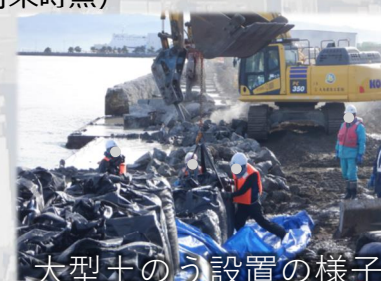
パラペット撤去の様子
