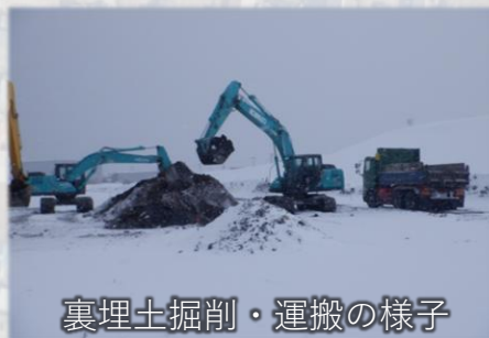
裏埋土掘削・運搬の様子
