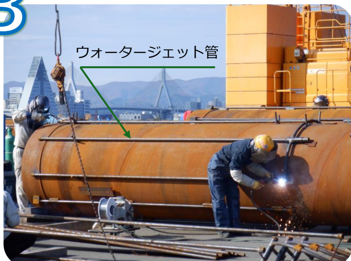
鋼管矢板にウォータージェット管を取り付ける
