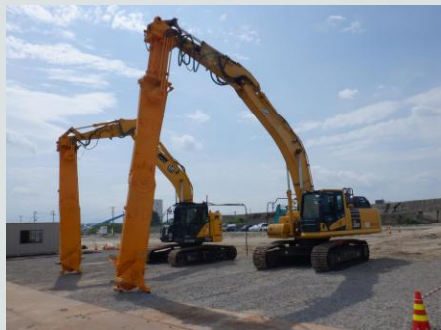
↑中層混合処理工法 ロータリーブレンダー＆プラント設備↑
