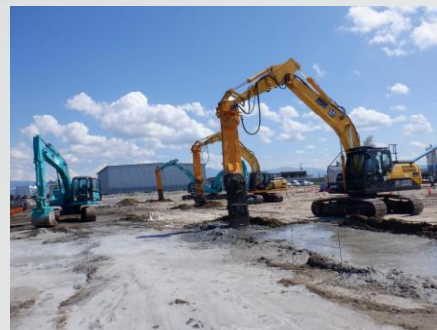
↑中層混合処理工法 施工中の様子↑
