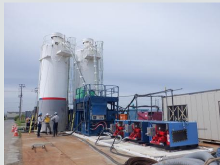
↑中層混合処理工法 ロータリーブレンダー＆プラント設備↑
