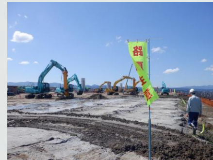
↑中層混合処理工法 施工中の様子↑
