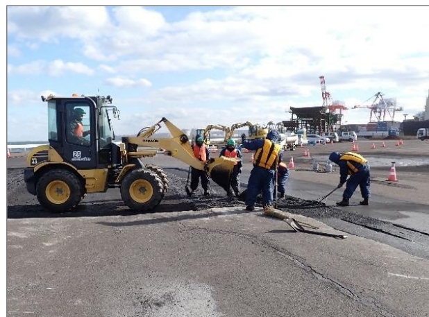
アスファルトコンクリート敷設
