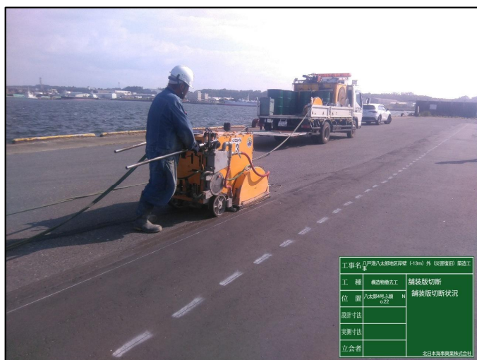
R8.7.7 既設舗装版切断状況
