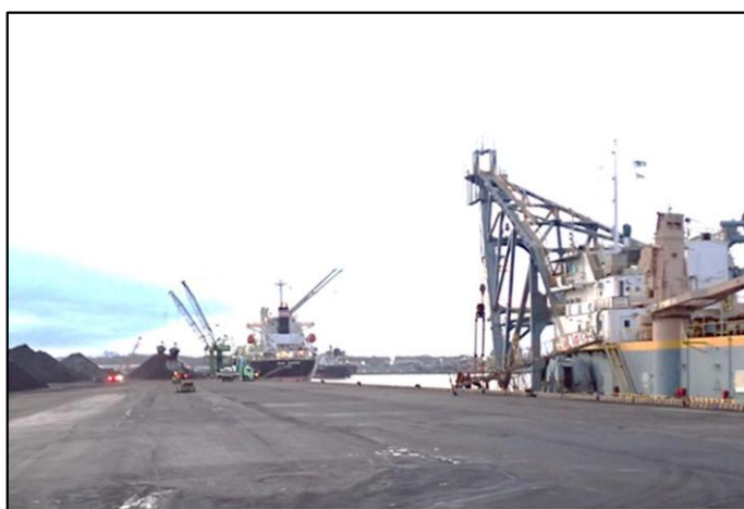
R7.12.20応急復旧完了
