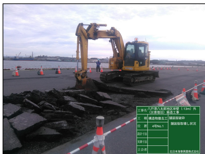
R8.8.19 既設舗装版撤去状況
