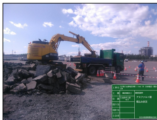
② R8.9.24 既設舗装版撤去状況
