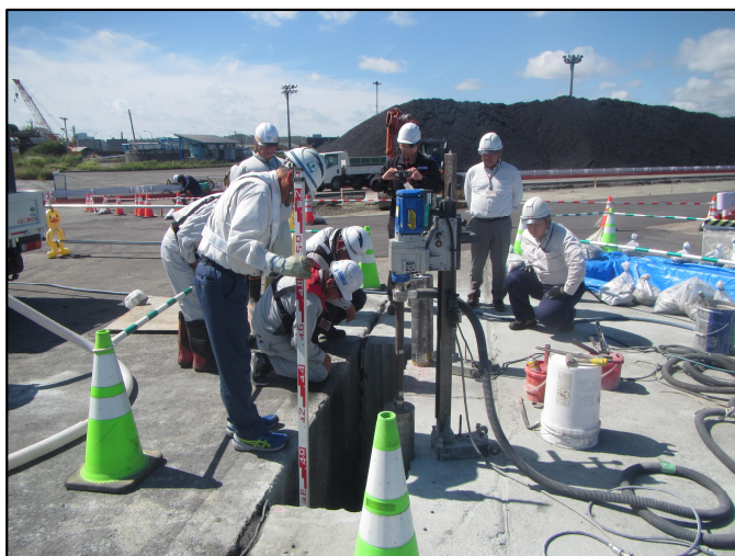
R8.9.8 吸出防止対策工に係る現地調査状況
