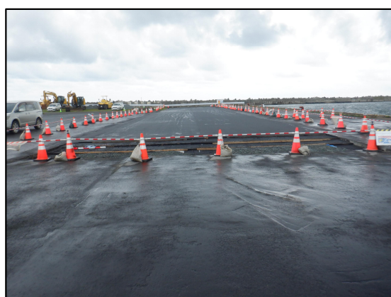
① R8.9.17 新設アスファルト舗装 施工完了状況
