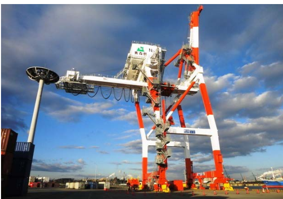
▲ガントリークレーン新1号機
