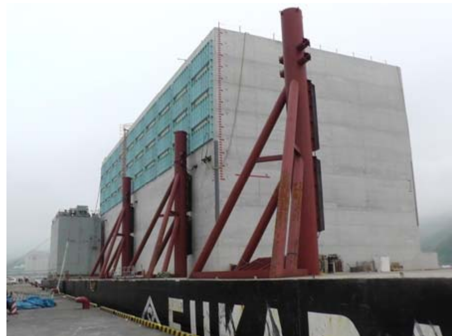
▲ HBケーソン接岸状況
