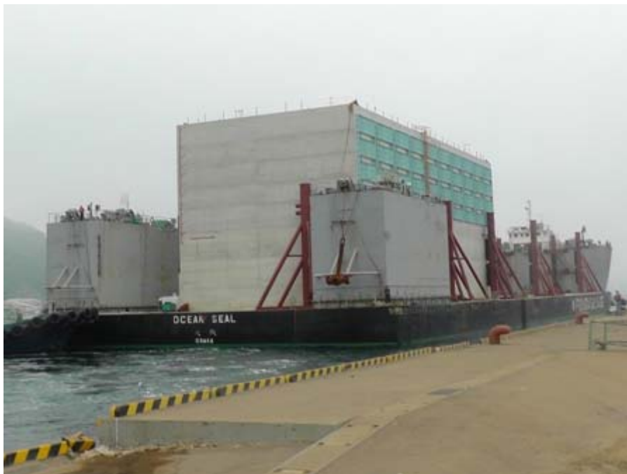
▲ HBケーソン入港状況
