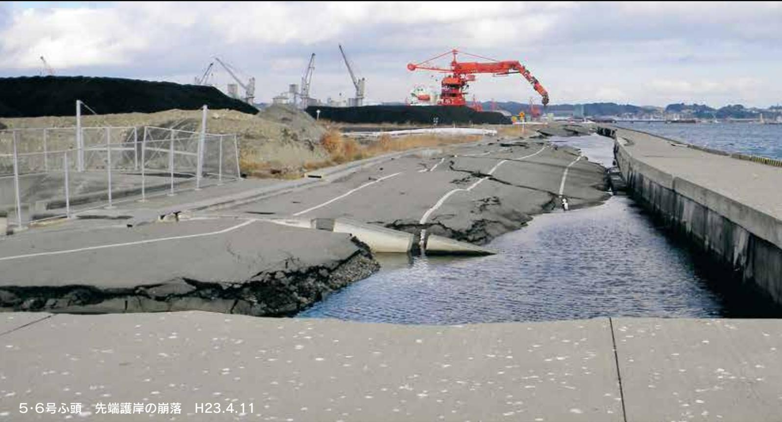
5・6号ふ頭 先端護岸の崩落 H23.4.11
