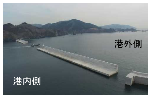
完成した湾口防波堤
