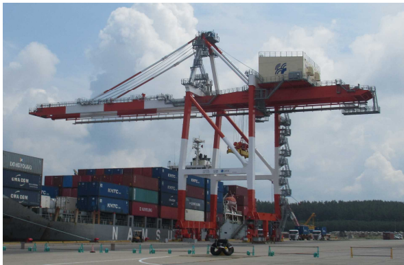
1号ガントリークレーン(令和2年8月29日撮影)
