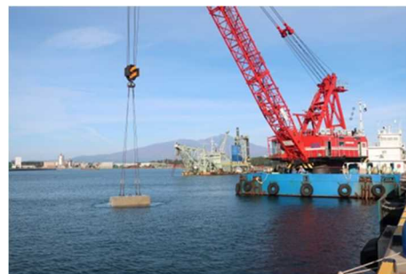
【起重機船による航路啓開】
