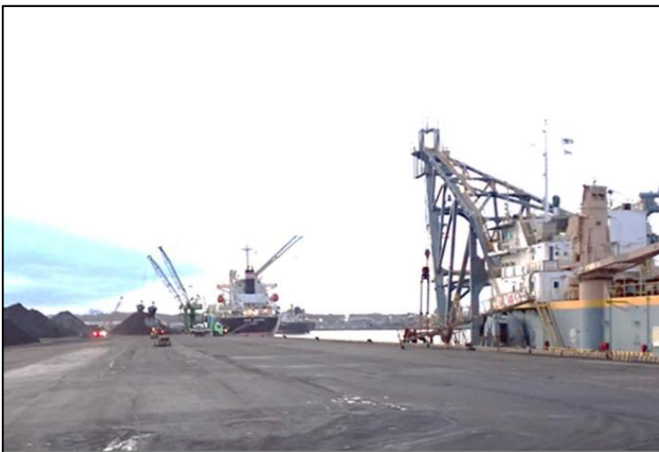
R7.12.20応急復旧完了
