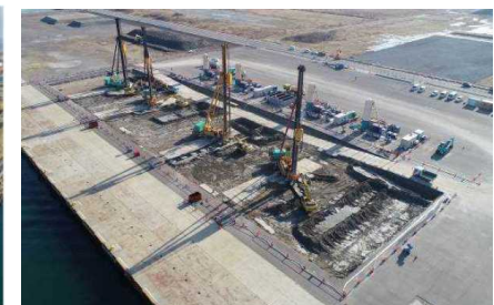
地盤改良工事(地耐力強化)
