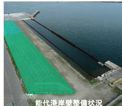
能代港岸壁整備状況
