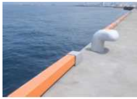
老朽化対策後
