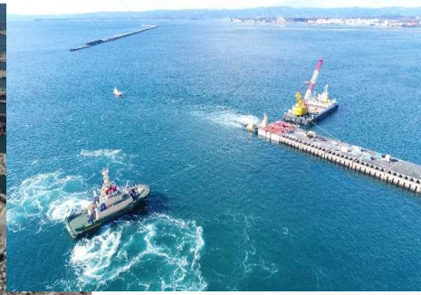
防波堤整備の様子(ケーソン据付)
