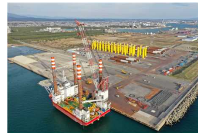
基礎構造部材のヤード使用状況
