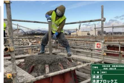
ブロック製作状況
