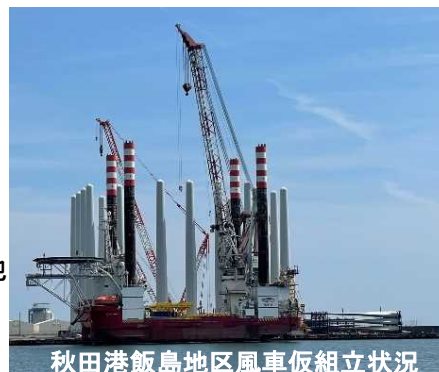
秋田港飯島地区風車仮組立状況
