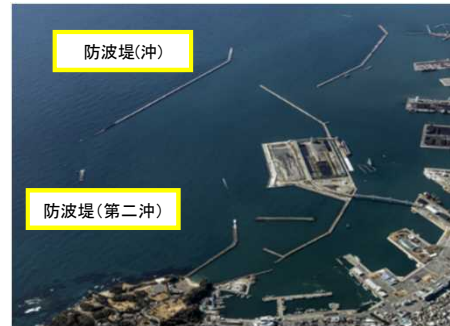
整備中の防波堤(沖)及び防波堤(第二沖)全景
