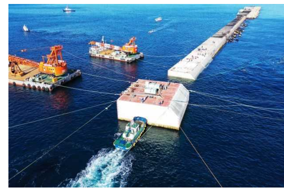
ケーソンの据付工事の様子
