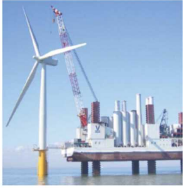
風車の据付工事、SEP船等の作業船の新造
