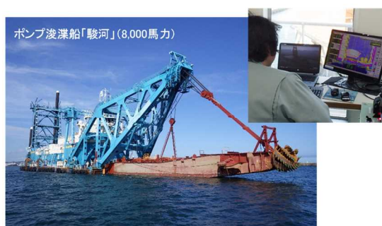
GNSSと潮位観測システムを活用した浚渫状況確認
