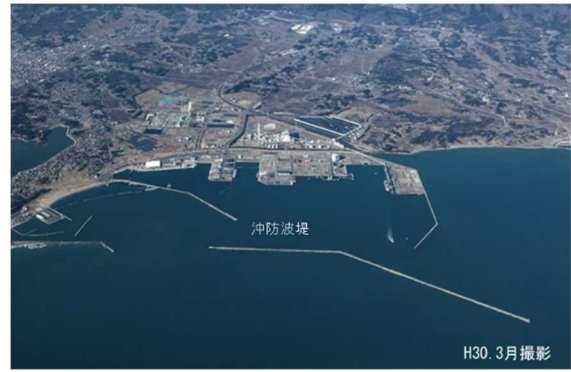
【相馬港・沖防波堤(復旧完了後)】
