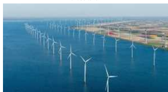
オランダ洋上風力発電所(出典:JWPA資料)
