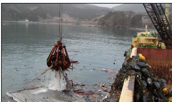
航路啓開・障害物の除去（大船渡港）
