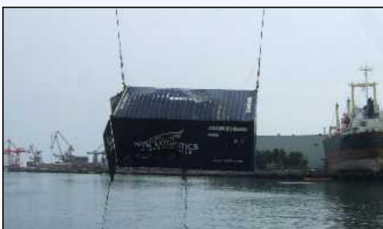
航路啓開・コンテナの揚収（仙台塩釜港）
