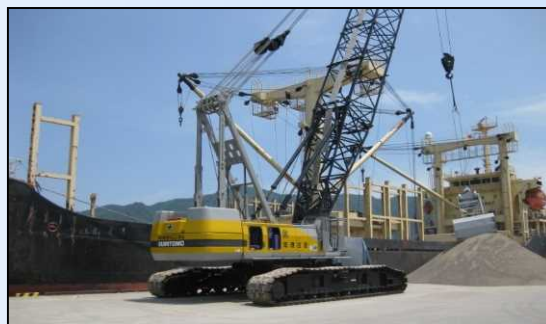
大型荷役機械の代替として導入された クローラクレーン（宮古港）
