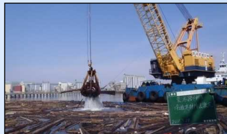
流出した木材の除去(仙台塩釜港石巻港区)
