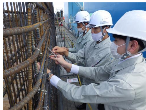
鉄筋の結束作業
